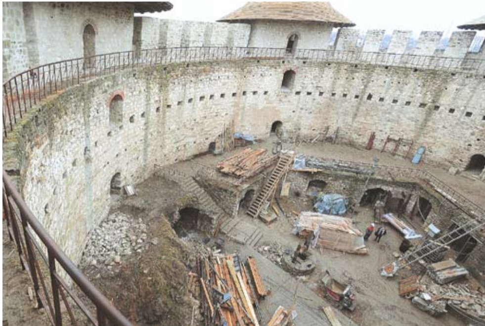
Ремонтные работы внутри крепости. Фото: Константин Григорицэ
