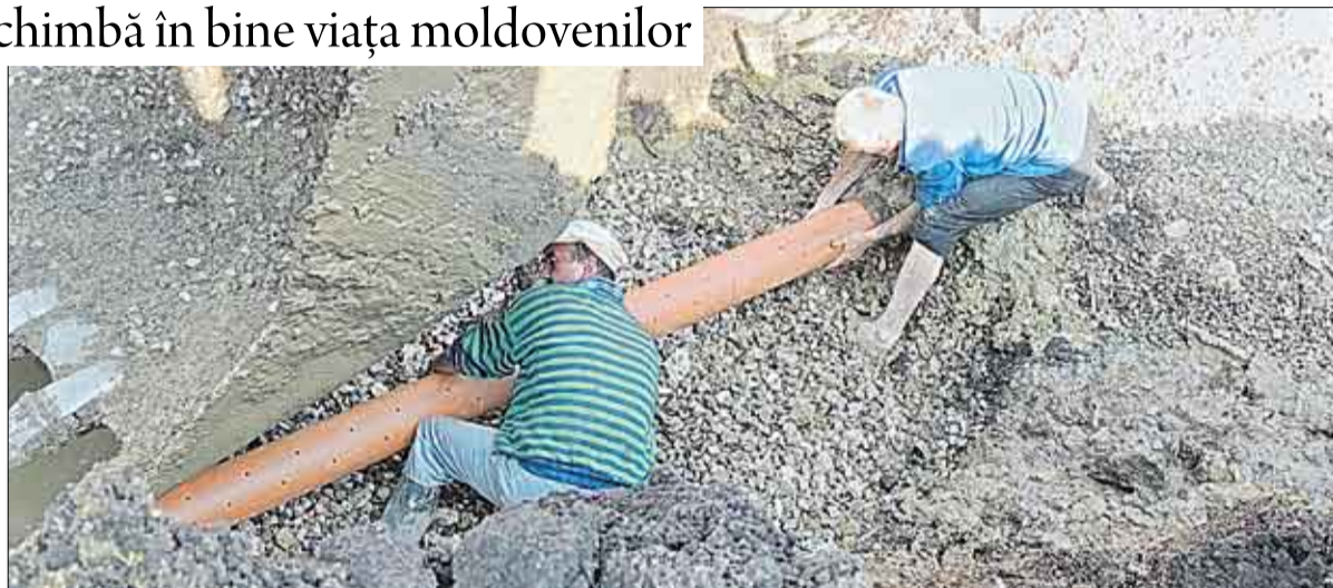
Lucrările de construcție a rețelei de apeduct din Cărpineni, Hâncești.
