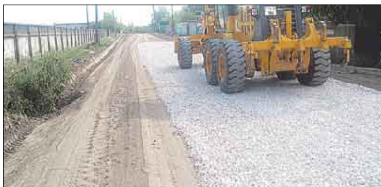
Renovarea unei porțiuni de drum din Cărpineni
