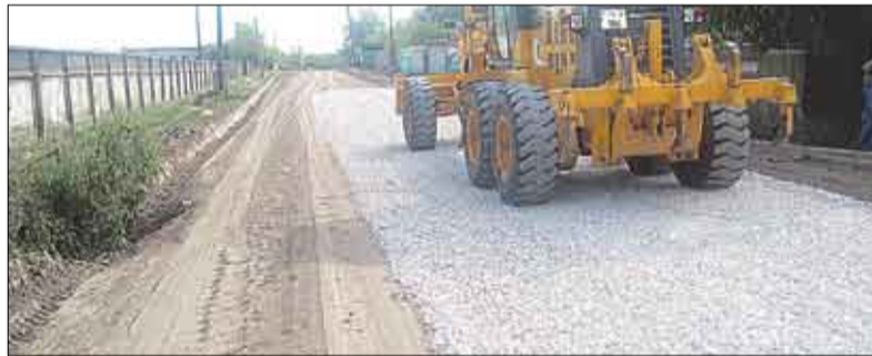
Ремонт участка дороги в Кэрпиень
