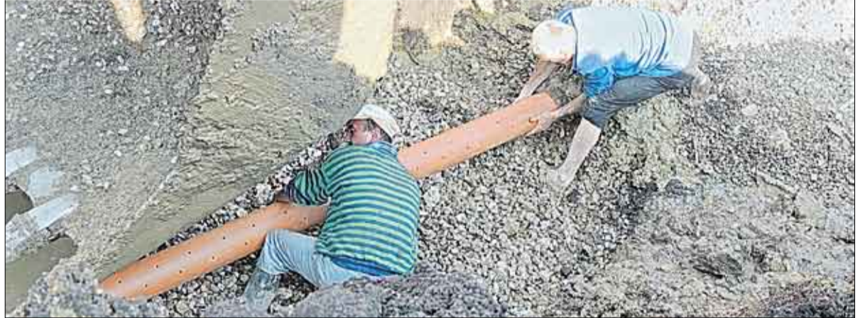
Работы по прокладке водопроводной сети в с. Кэрпиень (Хынчешть)
